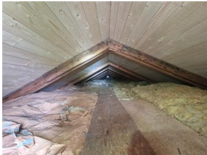
Vy på vindsutrymmet
