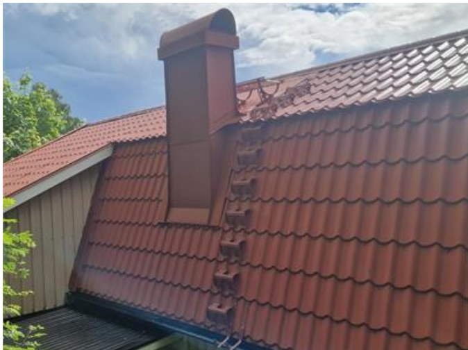
Vy på yttertak
