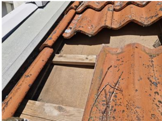
Tak, underlagstak av träfiberskivor.
