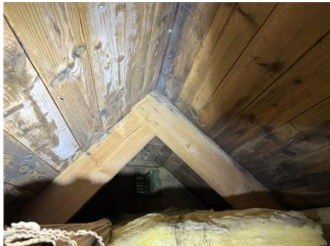
Bilden visar vy av vind.
