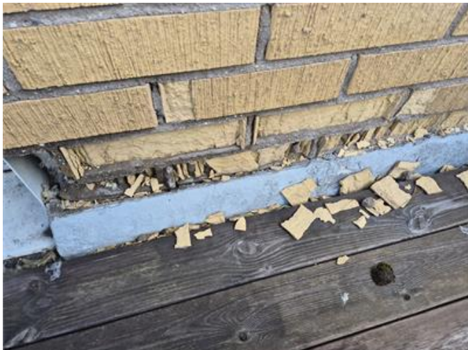
Frostsprängning tegelfasad.
