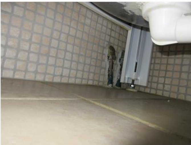
Rör genomföringar i golv under badkar
