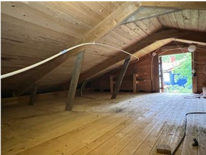
Vy i del av vindsutrymmet.
