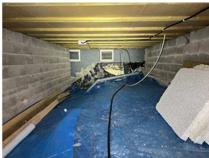
Krypgrund nyare del.
