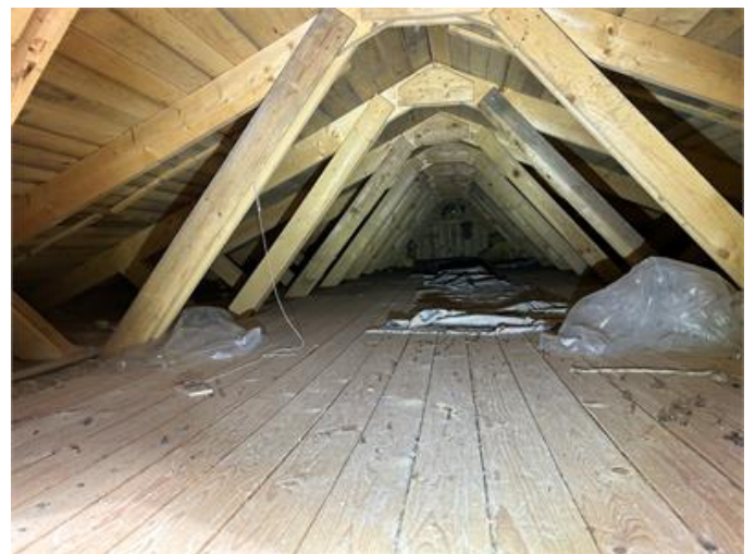
Nockvind norr: Översiktsbild.
