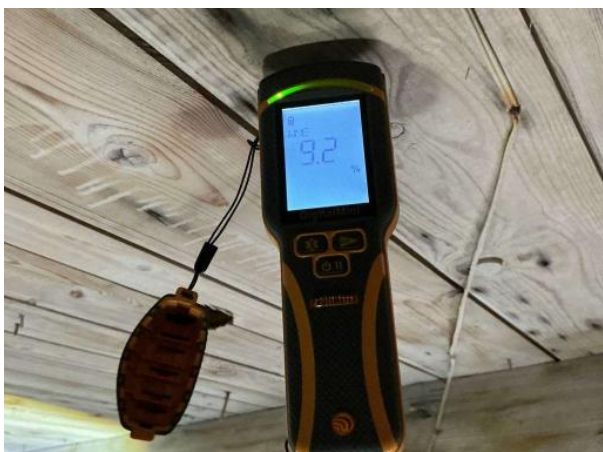
Bild 1: - Utvändigt, Vind, Inga förhöjda fuktvärden på övrig vind
