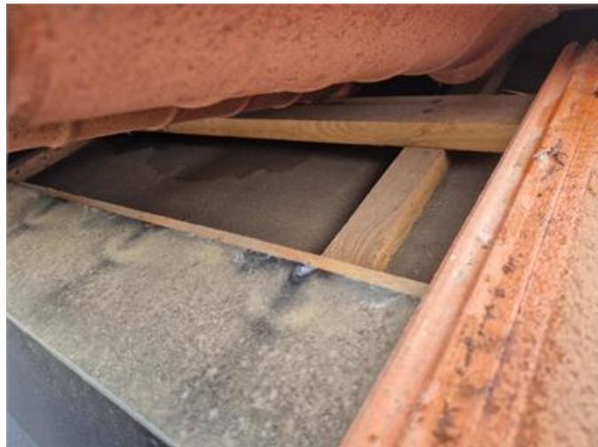
Vy på underlagstak
