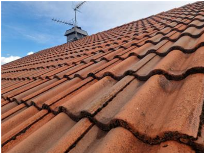
Vy på yttertak
