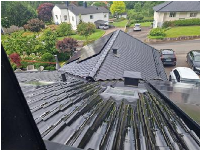
Vy på yttertak
