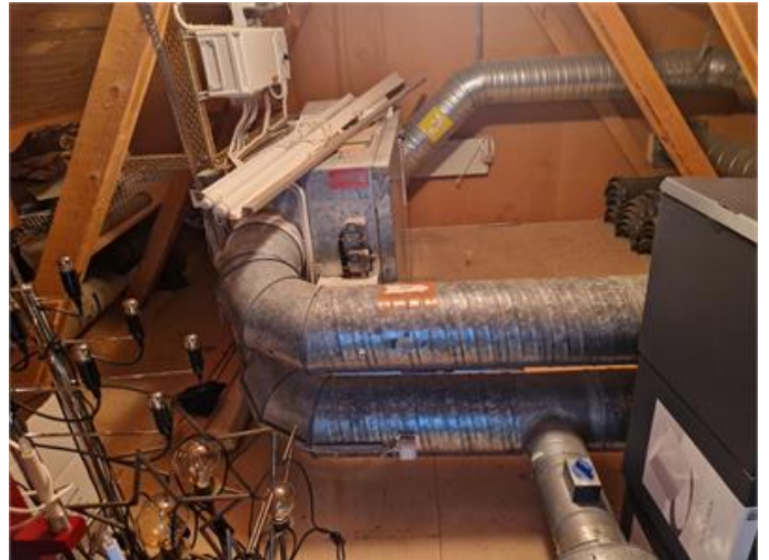
Vy på vindsutrymme med installation av FTX-ventilation
