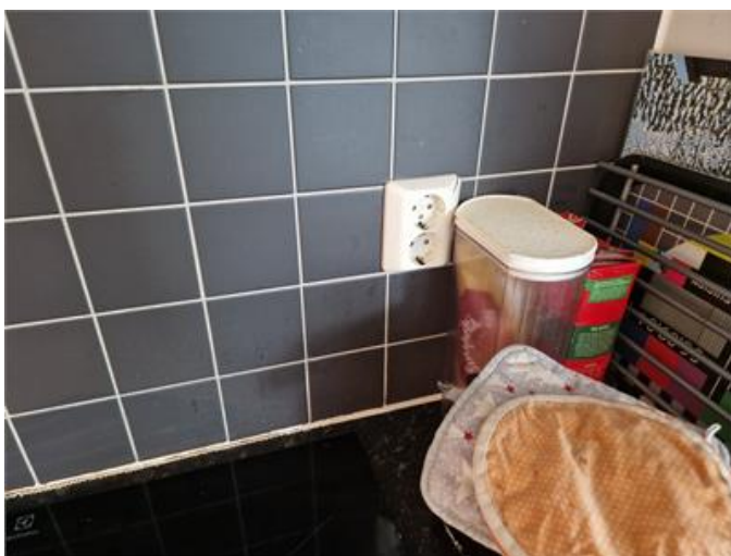
Kök: Eluttag placerat nära spishäll. Sprickor finns i eluttag.
