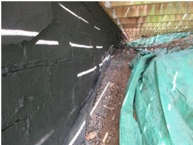
Kantlist släpper från grundmur
