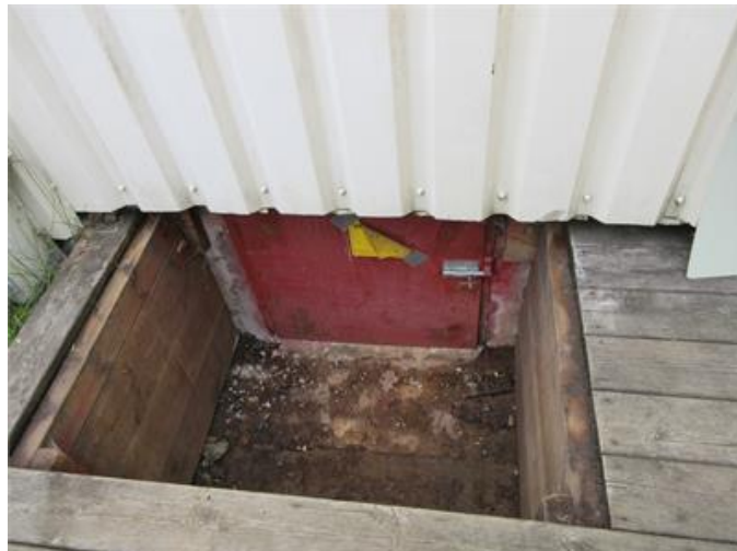
Lucka till krypgrund.
