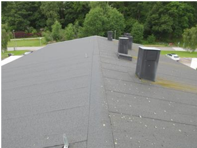
Bild visar takpapp på tak.
