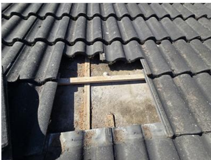
Tak: Stickprovskontroll under pannor, löv/främjöl samt tunnare ströläkt noteras.
