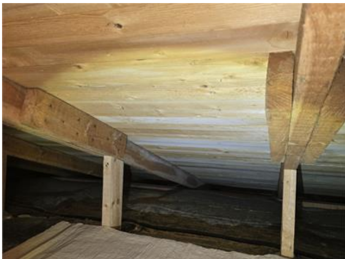
Nockvind: Vitaktig mikrobiell påväxt noteras på underlagstak.
