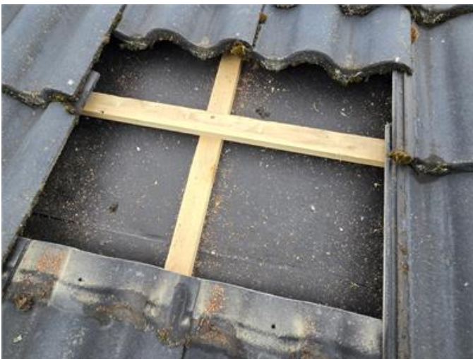
Tak: Stickprovskontroll under pannor.
