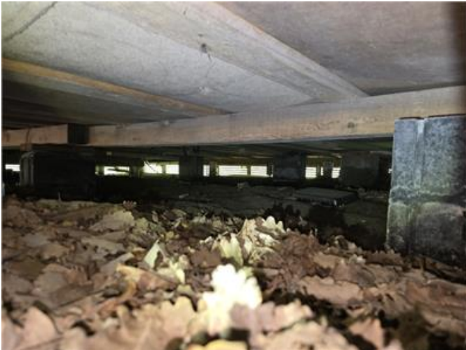
Plintgrund: Översiktsbild, rikligt med bl a. löv samt mikrobiell påväxt på blindbottenskvivor.
