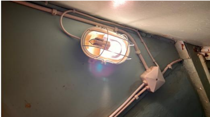
Sidan 10: "Sidan 10: "- Gnagare eller likande har ätit på elkabel ner till den invändiga källarutrymmet." - Åtgärdat, skadad kabel ersatt.
