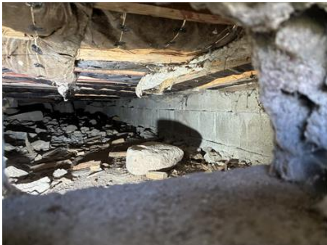
Krypgrund: översiktsbild tagen från uteluftsventil.
