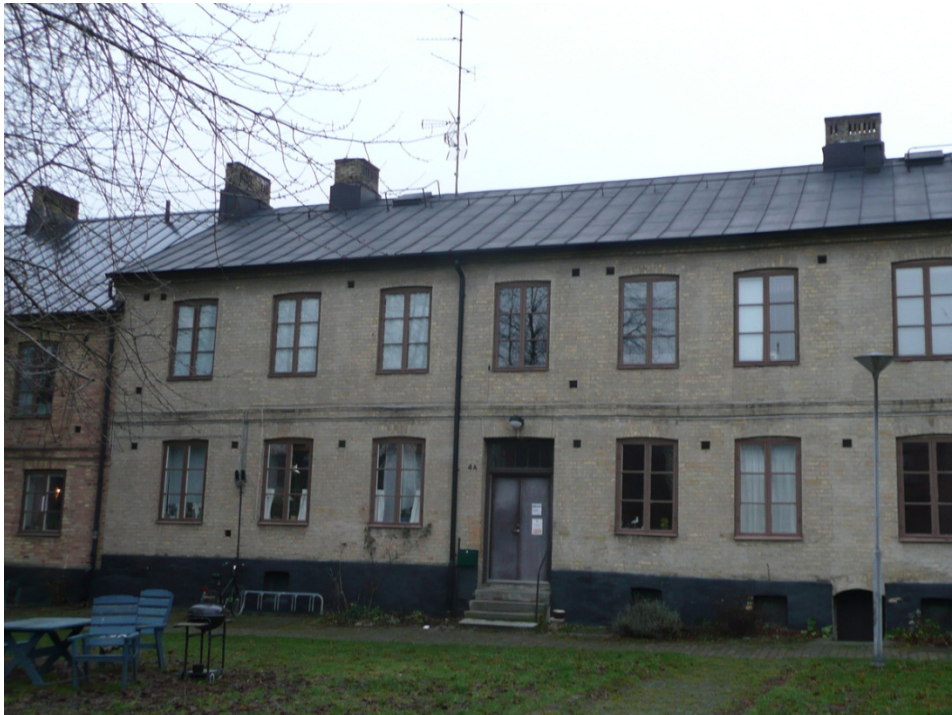
Fotot visar östra huset på fastigheten Själabodarna 15 med skivtäckt plåt på taket, tvåluftfönster och pardörrar i trä med överljus.
