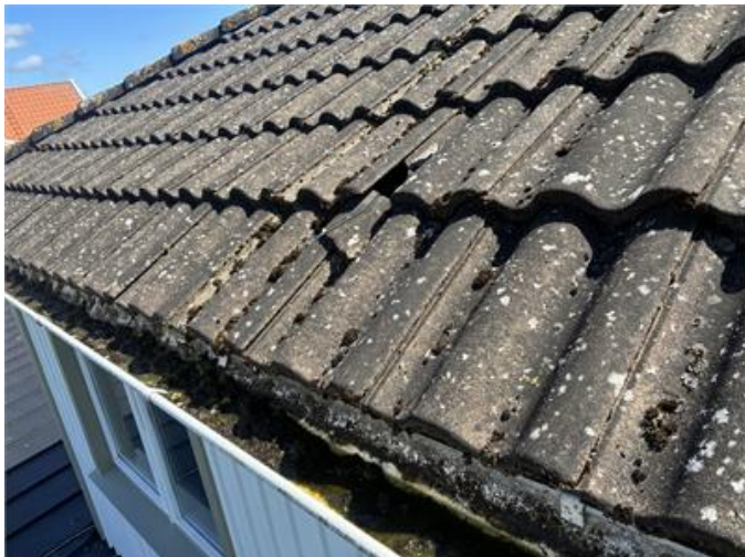
Tak pannor: Översiktsbild. Enstaka panna trasig. Bilden visar var lågpunkt finns på hänggränna.
