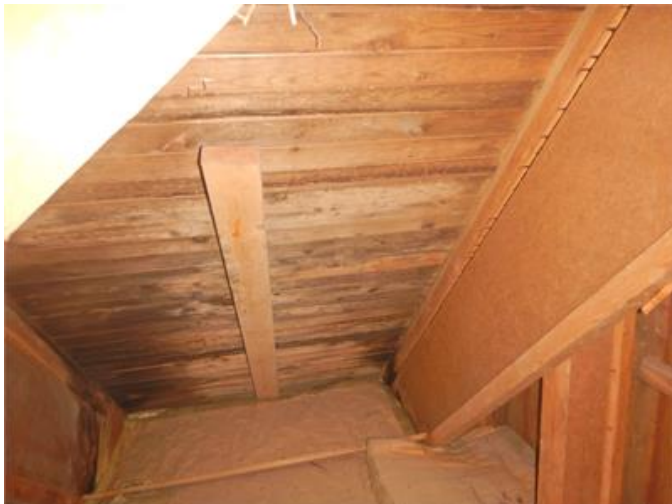
Mikrobiell påväxt på yttertaketets insida högre husdel
