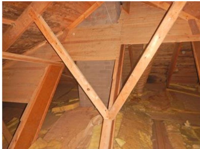
Snedsträvor till takstol klen förankrade
