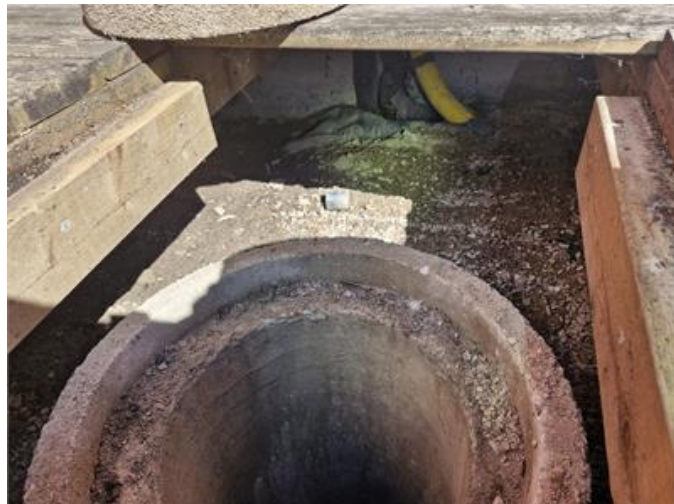
Mark, bild vid inspektionslucka altan med dräneringsbrunn.
