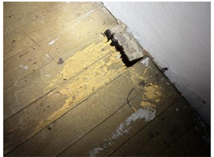
Äldre sanerade angrepp av husbock noterades i golv på vind som är kontrollerade av Anticimex enligt ägaren.
