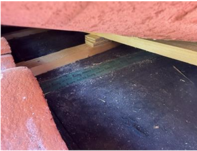
Stickprovskontroll av läkt och takpapp/dukt utförd utan anmärkning.
