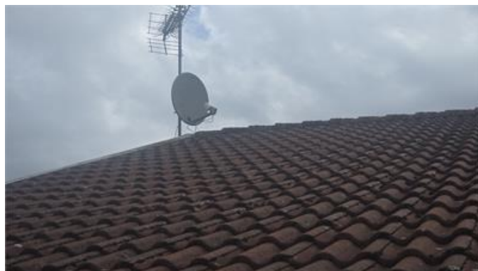
Översiktsbild, del av yttertak.
