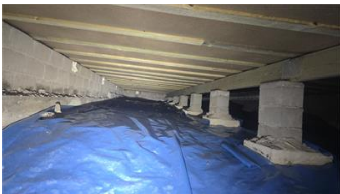
Översiktsbild, del av krypgrund.
