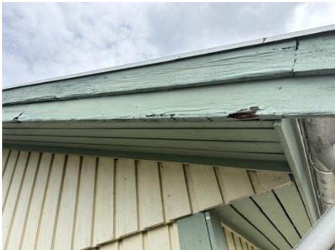
Bilden visar exempel på rötskador i trädetaljer (vindskivor).
