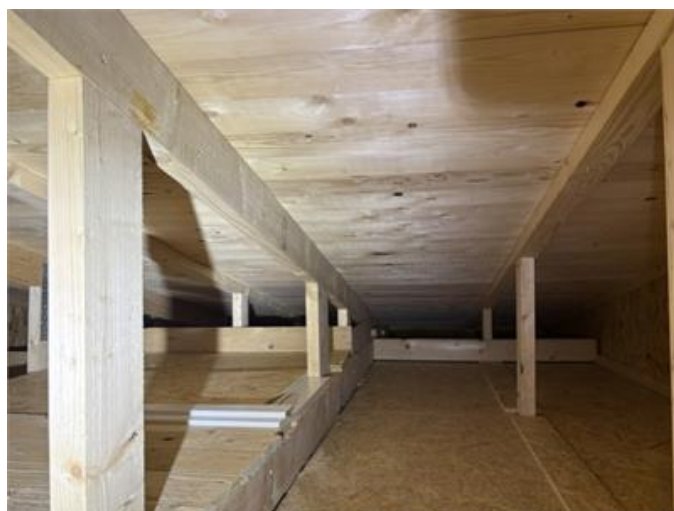
Bilden visar vy av vind (garage).
