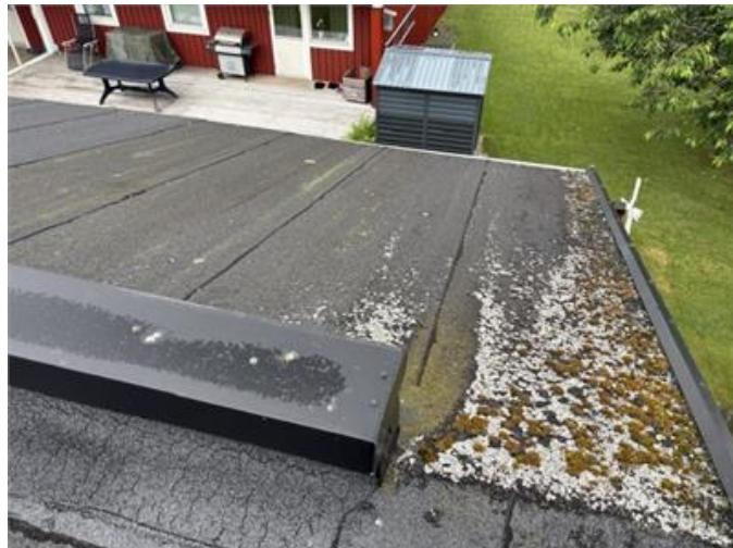
Bilden visar vy av den äldre delen av taket.
