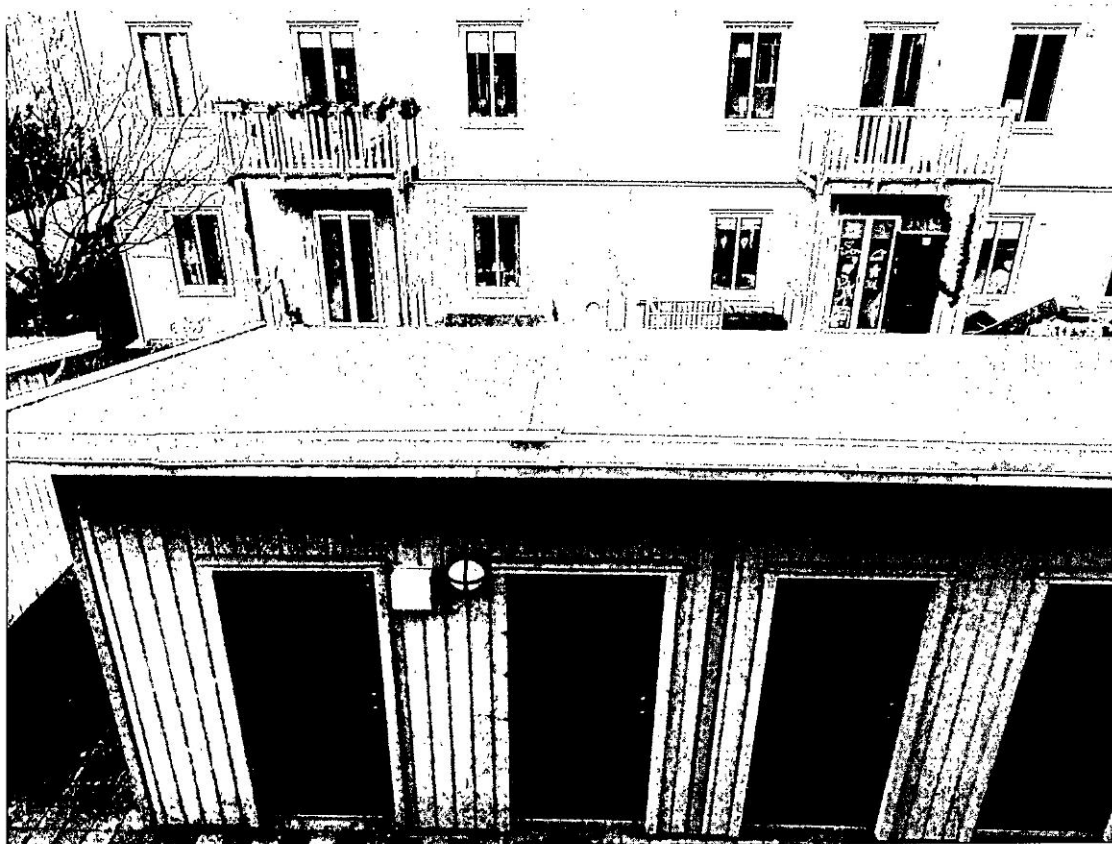
Plåt på takfot som behöver rengöras.
