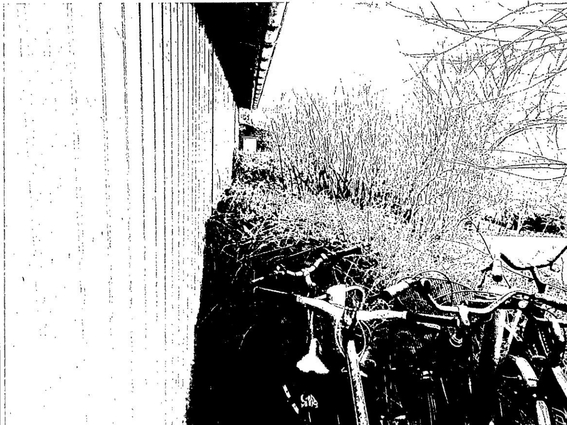
Exempel på när det är buskar som växer rätt mot fasaden. Buskarna måste omgäende bort.
