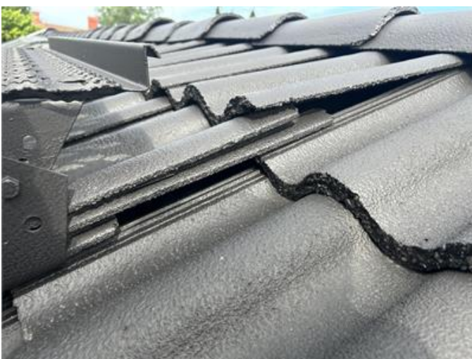
Tak: Otätheter i taktäckningen.
