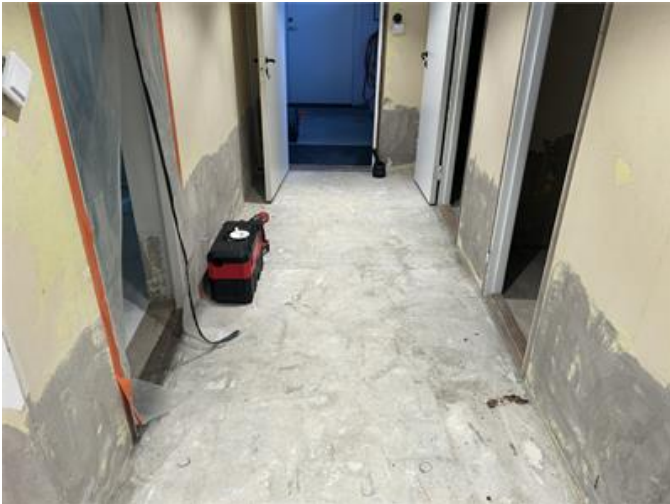
Källare: Under renovering av vattenskada.
