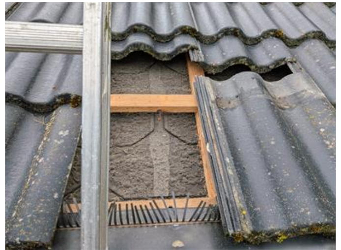
Nya takpannor är monterat på äldre tak med takpapp.
