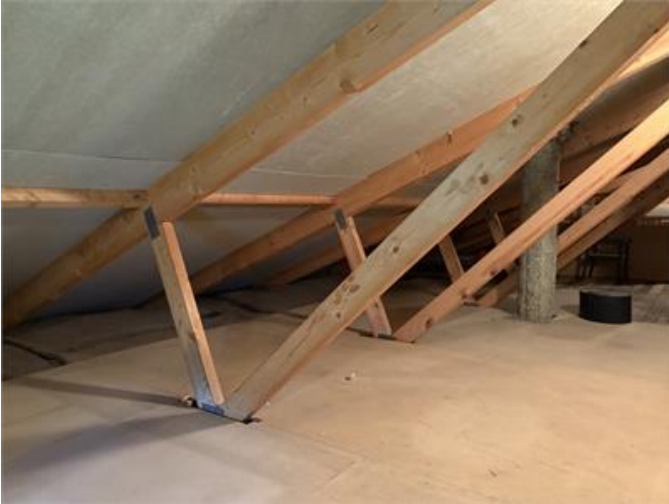
Vindsutrymme utan anmärkning.
