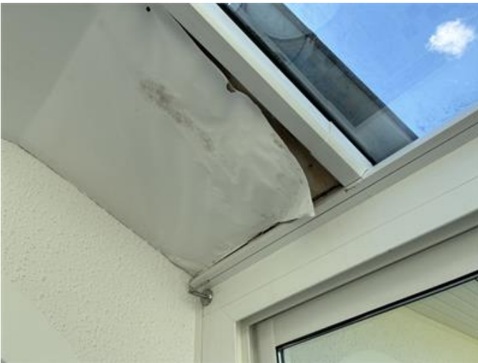
Uterum: Formförändring finns i tak, eventuellt läckage i takanslutning i uterum.
