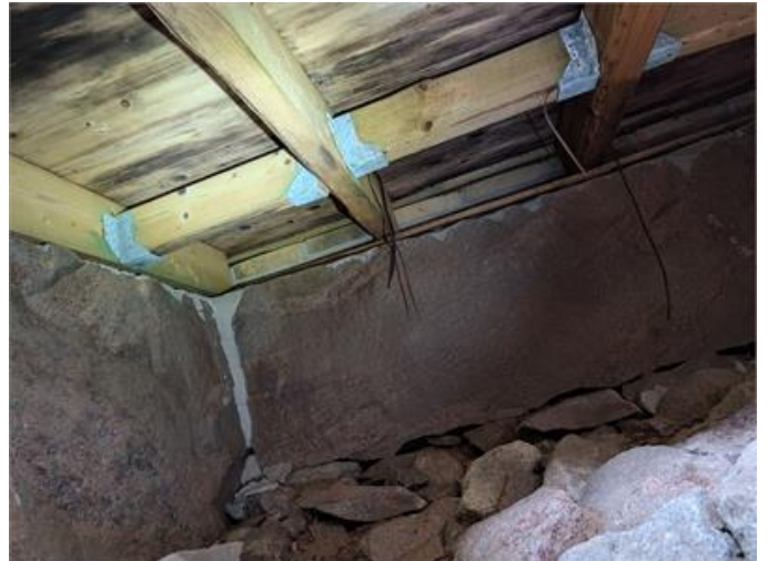
Torpargrund under veranda.
