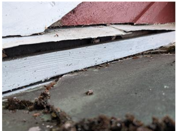
Otätthet vid fasad/takvinkel.
