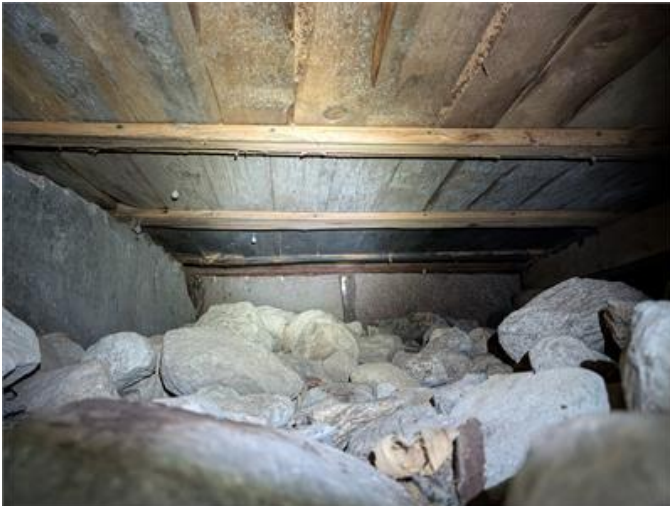
Torpargrund under bostadsbyggnad.
