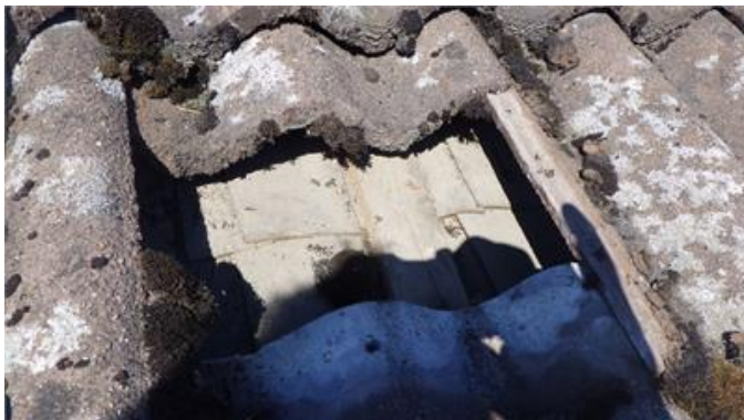
Underlagstäckning består av takspån.
