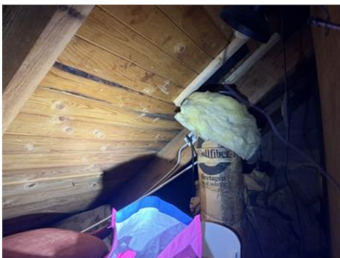
Allmän bild av besiktningsbart vindsutrymme
