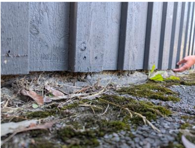
Fasad är lågt belägen utan sockelplåt.
