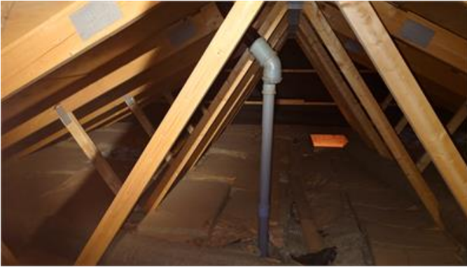
Vindens utrymme uppvisar inga tecken på fukt.
