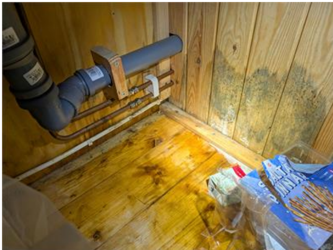
Pågående läckage med mikrobiell tillväxt i diskbänkskåp. Bild från vind.
