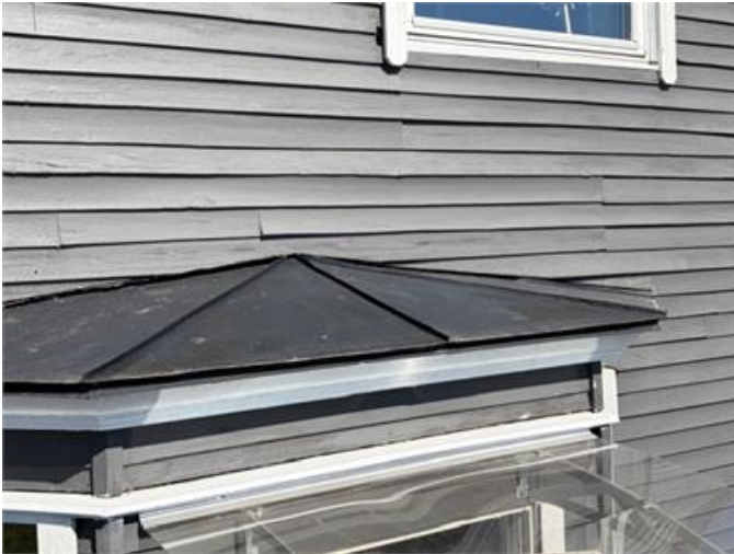
Plåttaket över burspråk förnyades inte. Inget avvikande noterades i plåten
