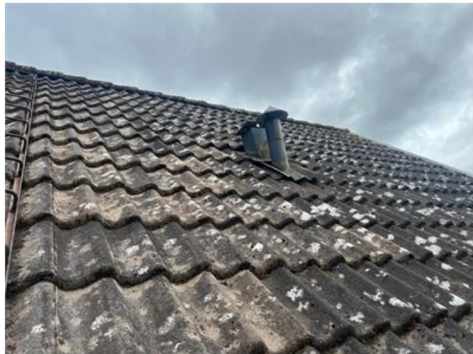
Taktäckningen är av äldre datum.
