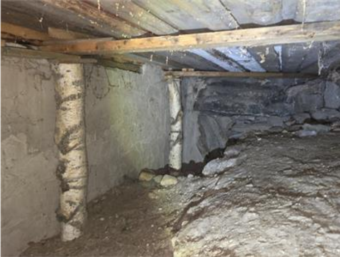
Torpargrund: Översiktsbild, stöttor av trä (grenar) noteras.
