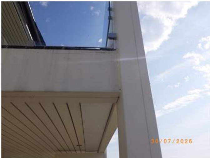
Lokal rötskada i balkongkonstruktion.
