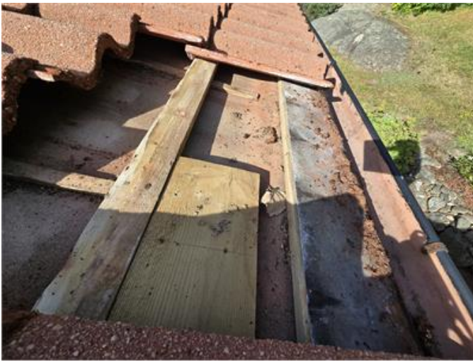
Tak: Stickprovskontroll under pannor vid takfot.
