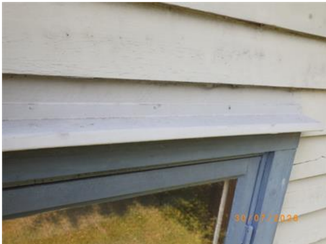
Överbleck monterat utanpå fasad.
