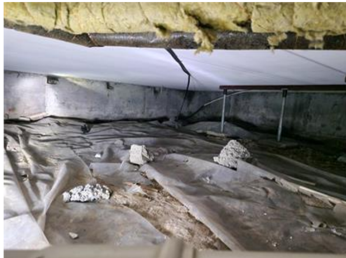
Vy, del av krypgrund.
