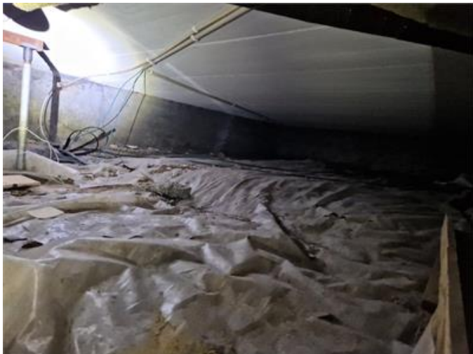
Vy, del av krypgrund.
