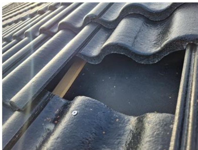
Vy på underlagstak med tunnare ströläkt.
