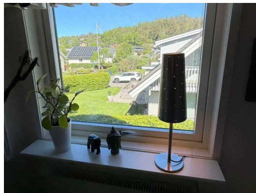
Bild 20: Not 6 - Invändigt vän 2, Sov 4, Original fönster från 1978
