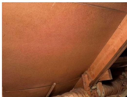
Bild 22: Not 8 - Invändigt vän 2, Vind, Massonit som underlag på yttertaket
