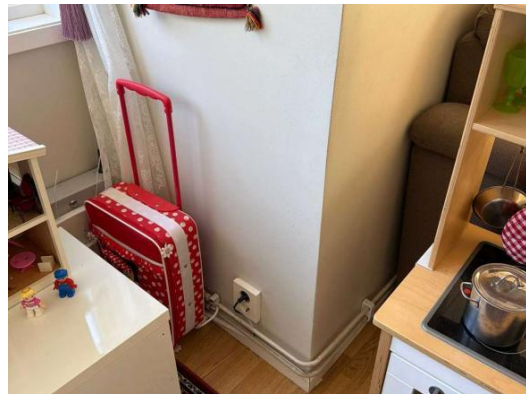
Bild 16: Info 12 - Invändigt vån 2, Allrum, Kattvindar saknar inspektionsmöjlighet
