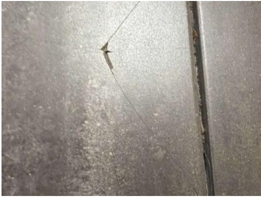
Bild 1: Info 1 - Invändigt, Entré, Spräckt klinkerplatta
