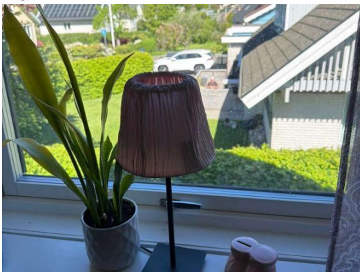
Bild 19 : Not 5 - Invändigt vän 2, Sov 3, Original fönster från 1978
