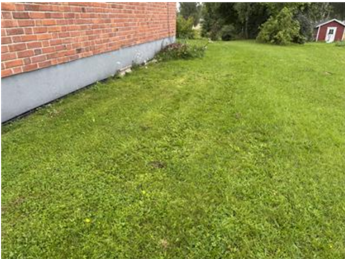
Fuktskyddsmatta synlig ovan mark på grundmur.
