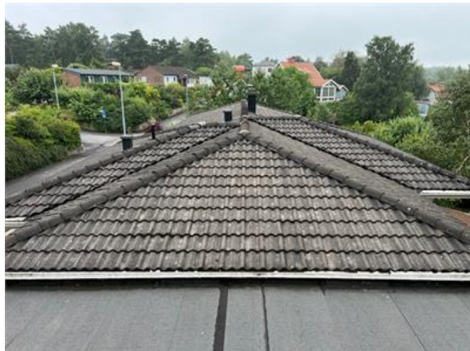
Taktäckningen är i originalutförande från 1998.
