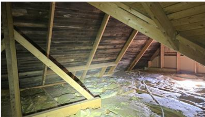
Översiktsbild, del av vind.
