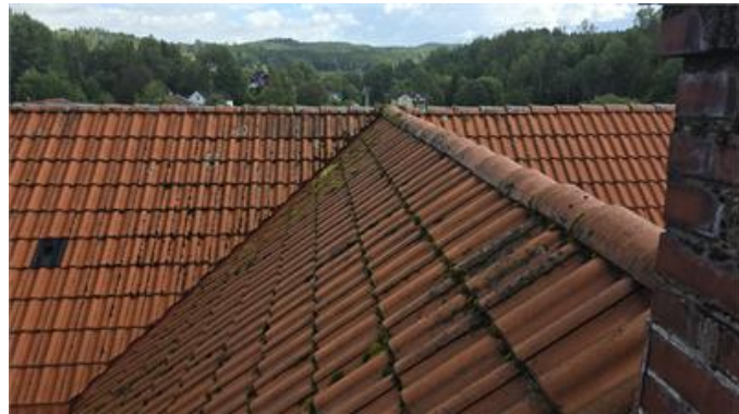
Översiktsbild, del av yttertak.
