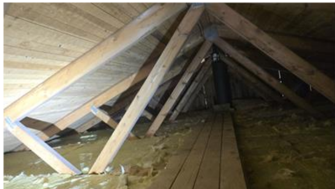
Översiktsbild, del av vindsutrymme.
