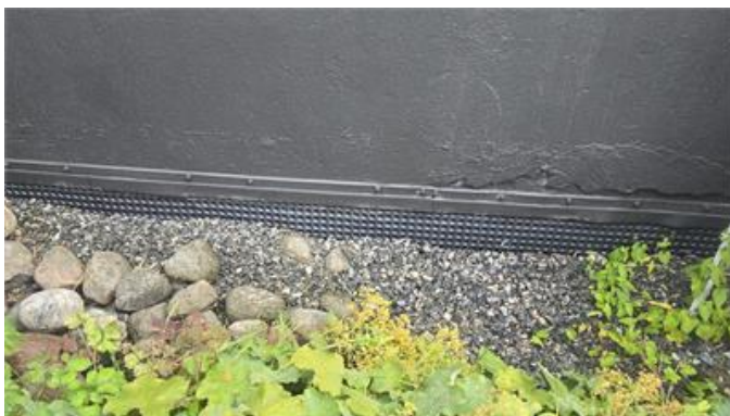
Del av utvändigt fuktskydd synligt ovan marknivå.
