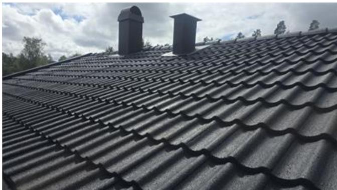
Översiktsbild, del av yttertak.
