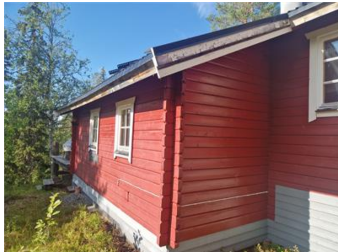
Fasad. Hängränna saknas på delar.
