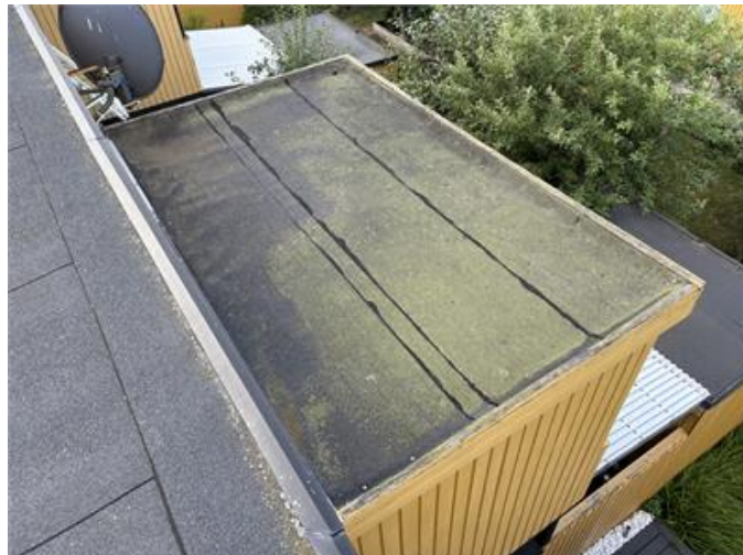
Översiktsbild från tak över balkong
